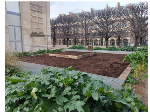
Expérimentation de mise en place d'un grillage pour prévenir des galeries de rats, 2025. © Musée du Louvre
