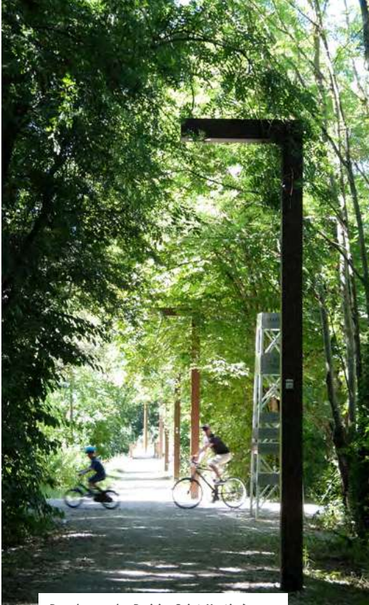
Dans le parc des Prairies Saint-Martin à Rennes (35), les mats d'éclairage ne sont pas présents partout, ils accompagnent les liaisons piétonnes et cycles. Ils sont équipés de détecteurs de présence et les sources lumineuses sont orientées vers le sol de façon à ne pas éclairer inutilement et ne pas gêner les animaux nocturnes. Concepteurs : Agence BASE
