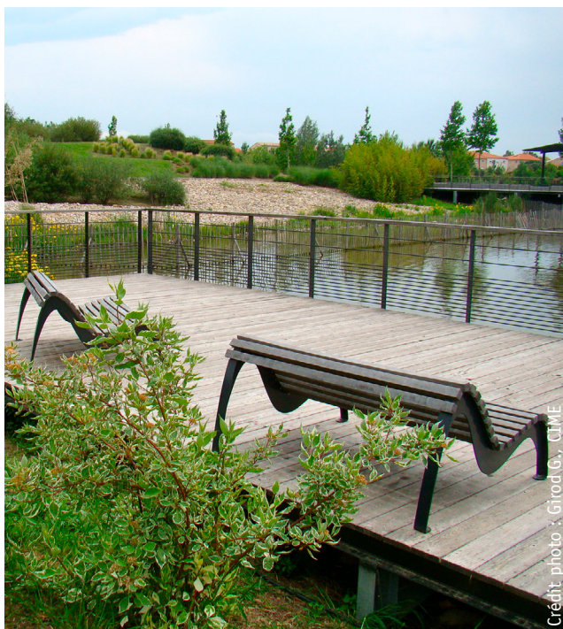
Ponton réalisé en mélèze (bois issu de la filière locale). Parc Saint Vicens, labellisé EcoJardin en 2013, Perpignan (66)
